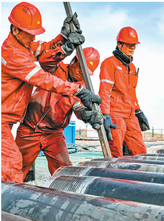
石油人在摆放即将入井的套管等钻工具。
