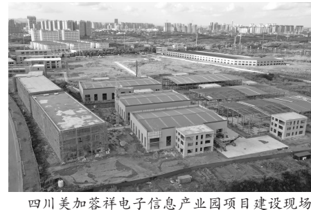
四川美加蓉祥电子信息产业园项目建设现场。
