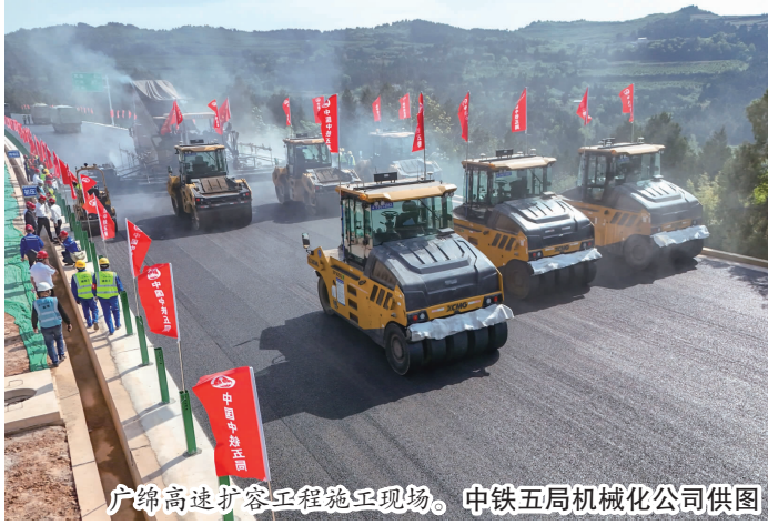
广绵高速扩容工程施工现场。中铁五局机械化公司供图
