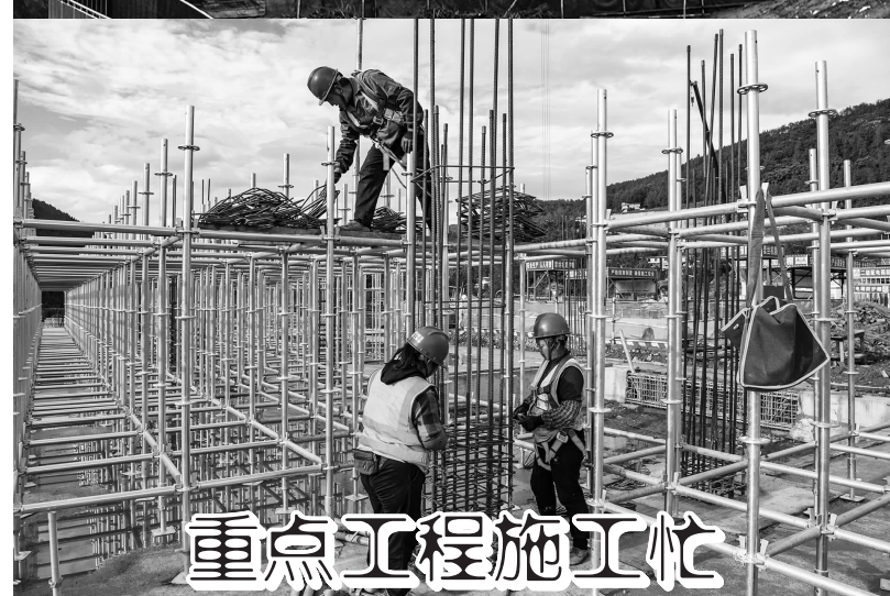
11月1日,巴中市通江县金堂工业园区四川能投巴中(通江)燃气发电工程项目建设现场,塔吊林立、机械轰鸣,工人各司其职、密切配合、紧张作业。据悉,该项目是四川省“十四五”电力发展规划中的气电项目,占地185亩,总投资约26亿元,将建设2套40万千瓦级燃气—蒸汽联合循环发电机组,建成投产后,预计可减排二氧化碳约81万吨。(程聪 摄影报道)
