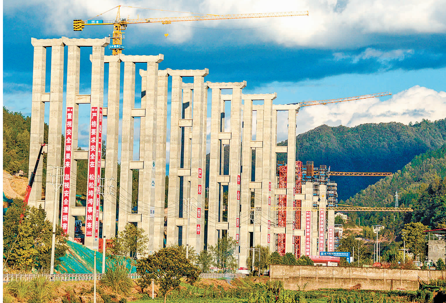
巴中市通江县是川陕革命老区核心区。近年来,该县大力推进交通基础设施建设,加快建成以高速为骨架、国省干道为支撑、县乡公路为脉络的综合交通运输体系。越来越完善的交通运输体系,不仅方便了群众出行,也推动了当地红色旅游快速发展,带动了老区人民增收致富。图为通江县正在修建的米仓山大道诺水河段。(程聪 摄影报道)
