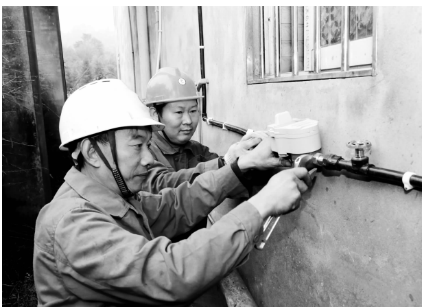
工人安装自来水管网。
