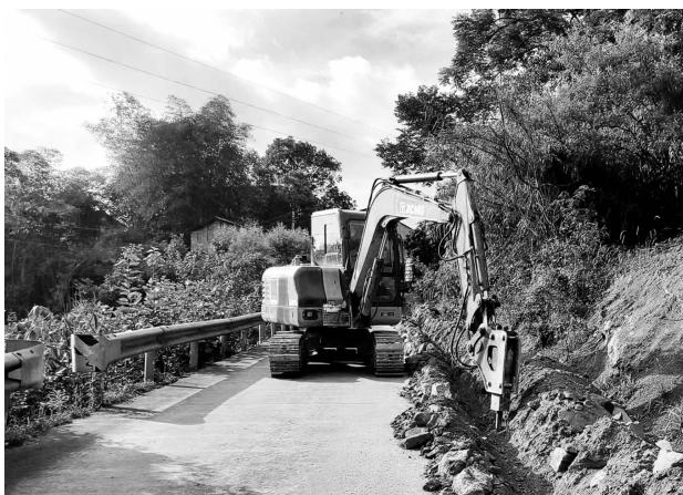
工人挖自来水管道。
