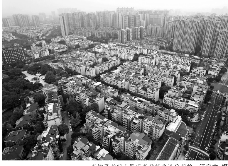
东城区老旧小区完成升级改造后新貌。江良文 摄
