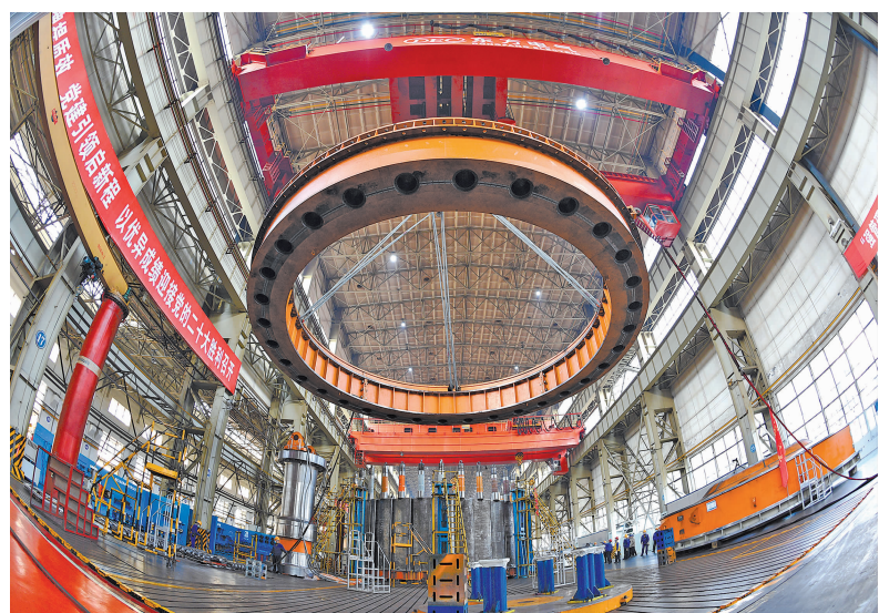
葛洲坝改造导水机构预装顶盖吊装
