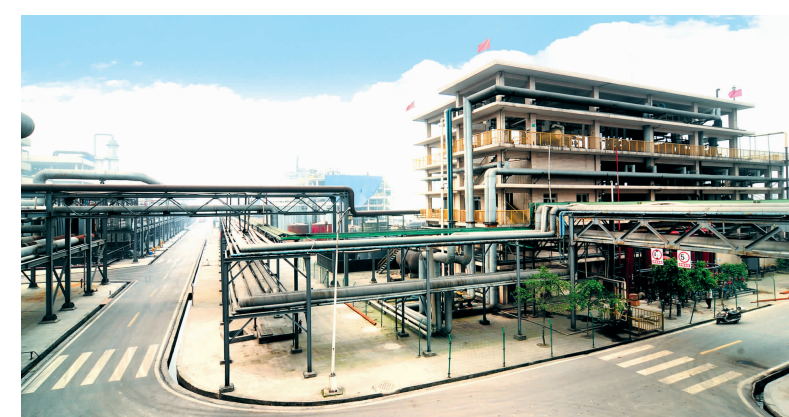
四川乐山福华通达农药科技有限公司生产车间。
