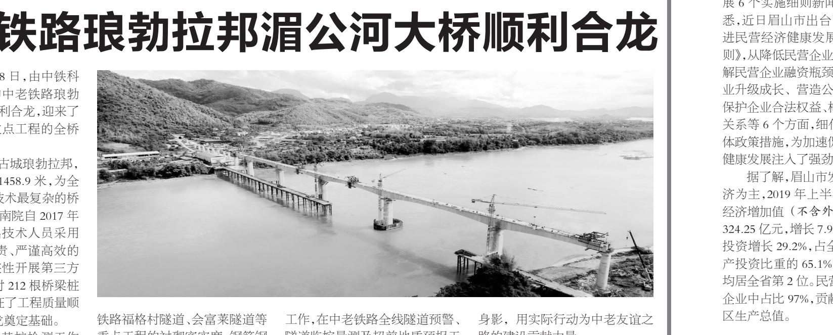
大桥位于老勒古城琅勃拉邦,横跨涪公河,全长1458.9米,为全线施工难度最大、技术最复杂的桥梁。中铁科工西南院自2017年3月进场以来,5名技术人员采用低应变法,高度负责、严谨高效的对该桥梁基桩完整性开展第三方检测工作,完成了对212根桥梁桩基的诊断把脉,保证了工程质量顺利验收,为大桥合龙奠定基础。
