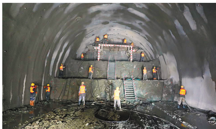
使用微台阶施工工艺修建成昆铁路复线邓家湾隧道
