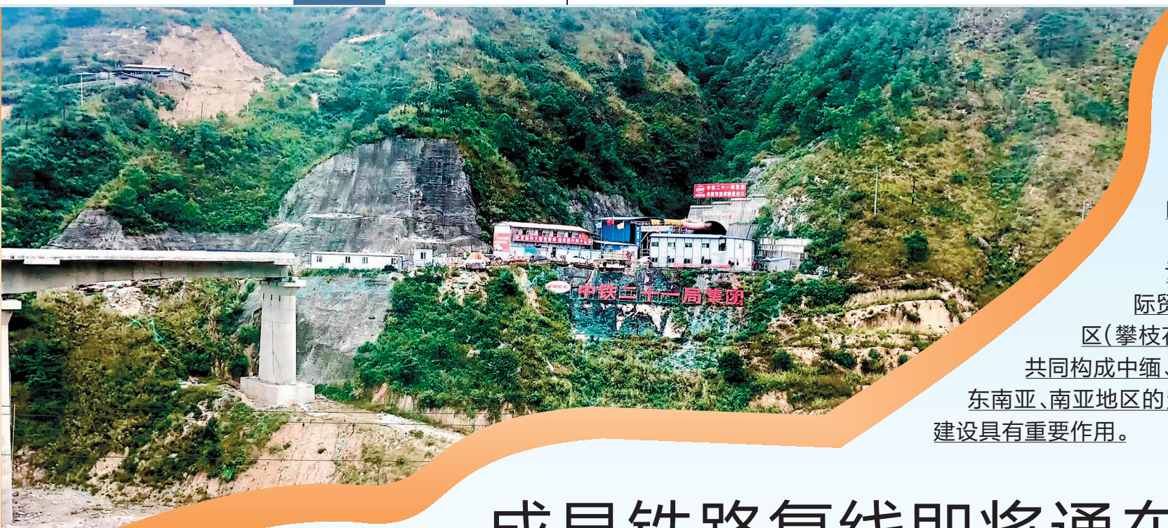
成昆铁路复线邓家湾隧道出口全貌
