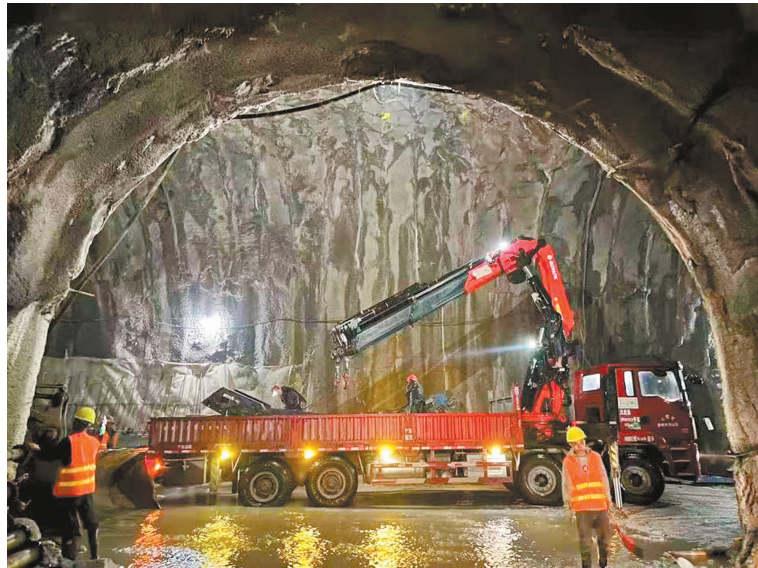
成昆铁路复线邓家湾隧道平导与正洞连接处施工现场
