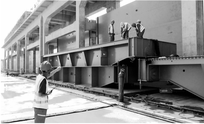
巡逻各施工点位
