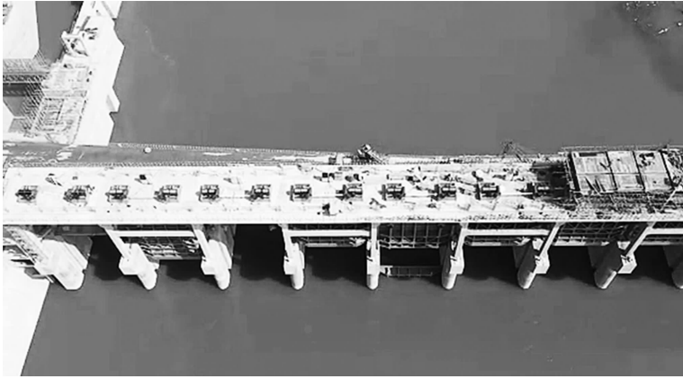
项目建设现场
