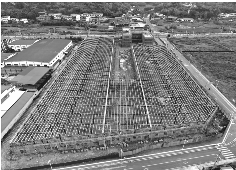
佳龙食品项目建设现场。
