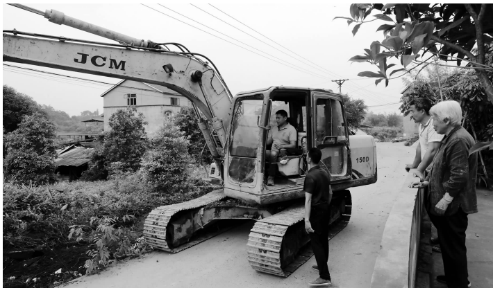
挖掘机正在拓宽乡路
