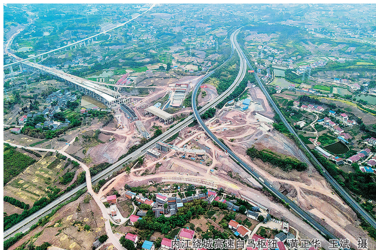
内江绕城高速白马枢纽 黄正华 王斌 摄
