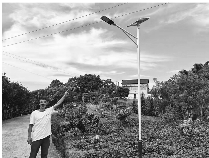
杨朝元介绍新安装的路灯
