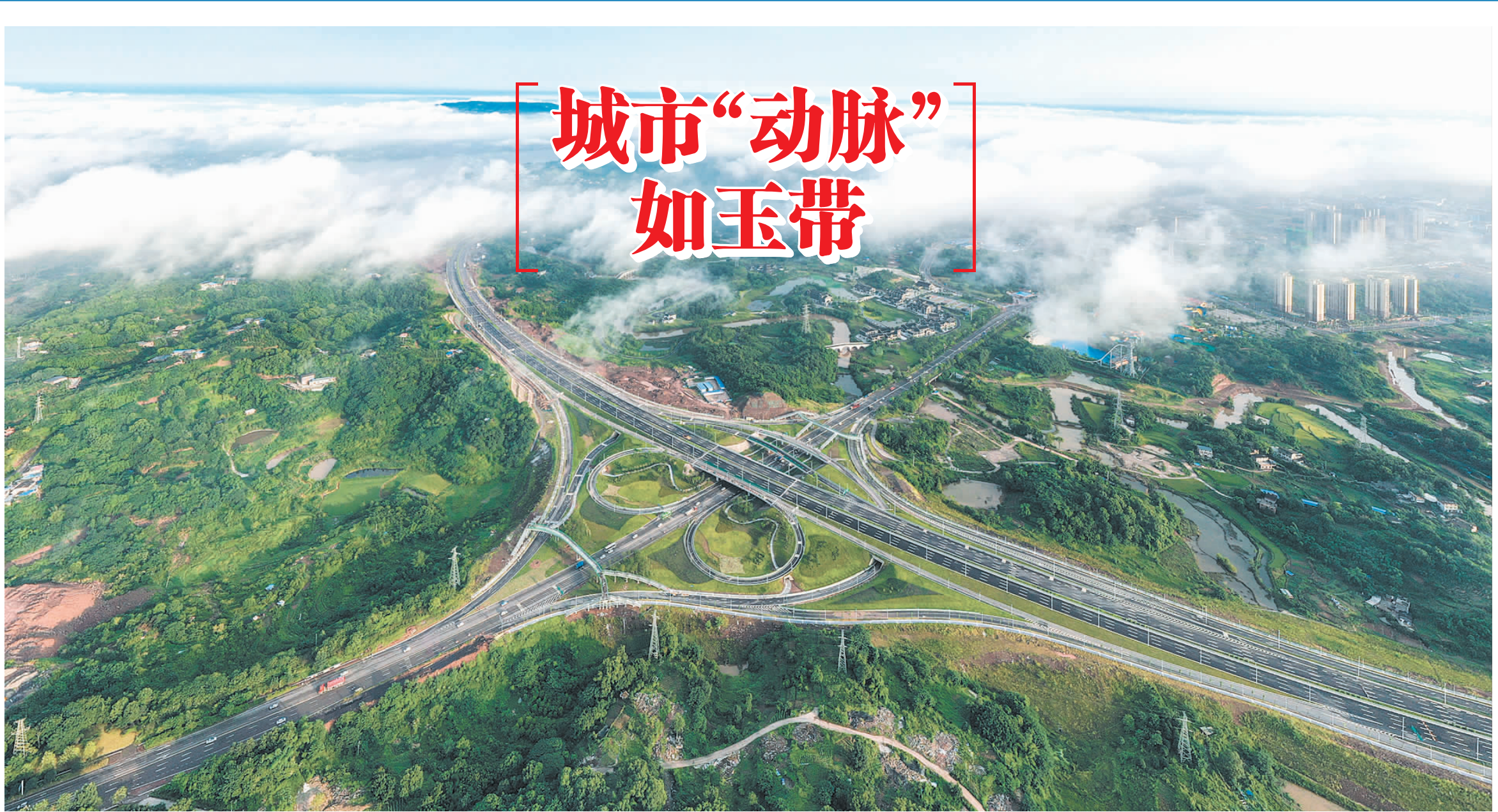
图片新闻 近日，泸州市纳溪区境内的泸州市二环路交通枢纽在清晨的云雾中若隐若现，犹如一条飘动的玉带。泸州市二环路是构建泸州市“四横六纵两环五联络”骨架路网中的重要组成部分，也是规划泸州城区轨道、快速公交的重要载体，建成后将缓解交通压力，大力促进经济发展，提升市民幸福生活指数。(廖胜春 王国中 摄影报道)
