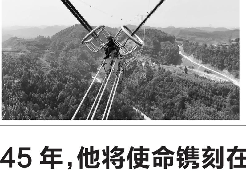
国网四川超高压公司乐山运维分部员工开展±800千伏金上一湖北特高压直流输电线路工程川12标段验收走线。
