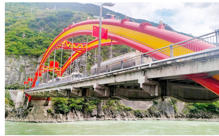
专家现场检查桥梁安全
