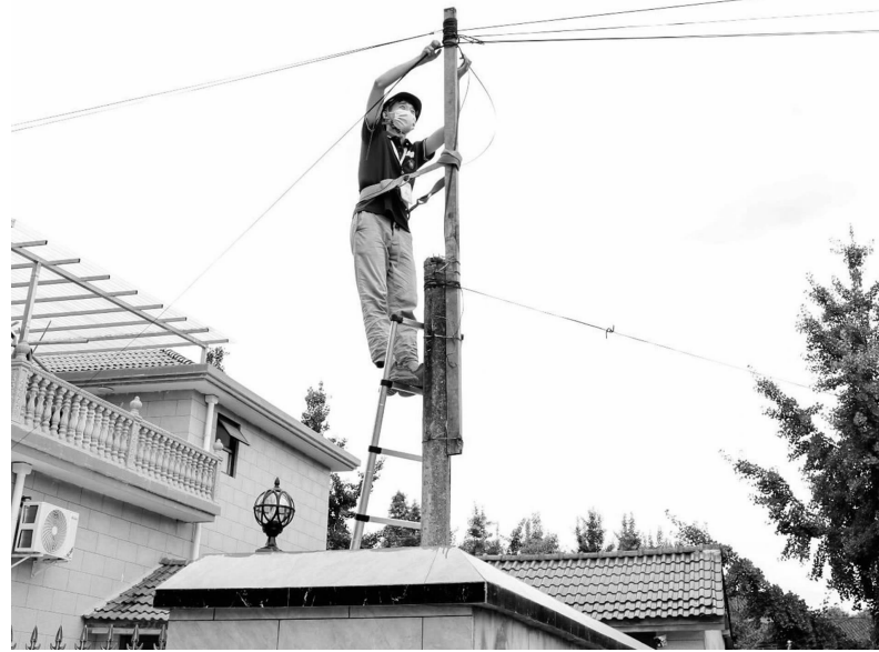
工人实施安装作业
