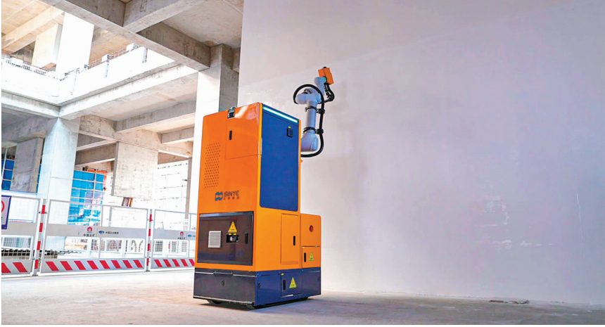
智能喷涂机器人进行喷涂作业示范。新华社发
