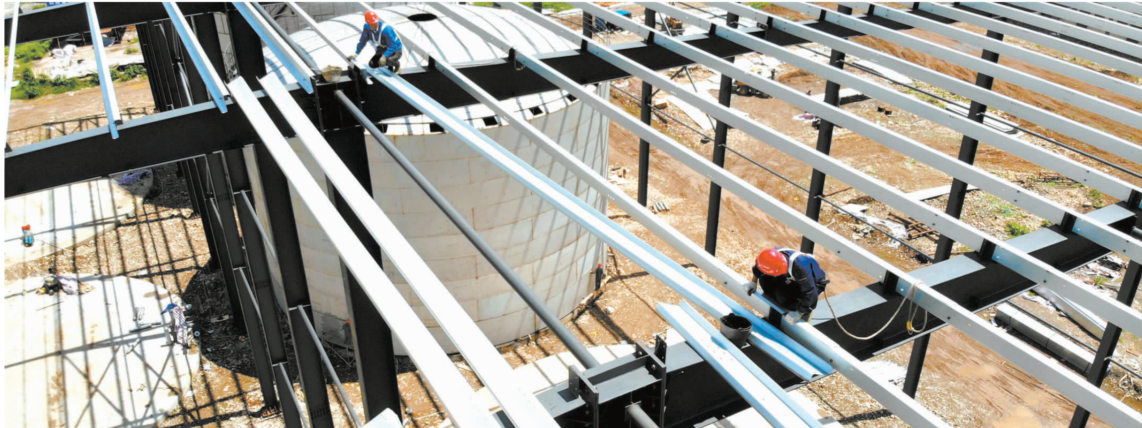
么麻子项目建设现场
