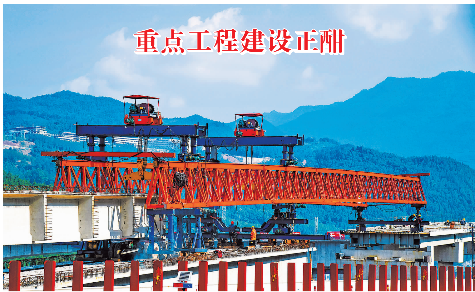
6月15日,在位于巴中市通江县的镇(陕西镇巴县)广(四川广安市)高速通江东互通施工现场,建设者们正在加紧作业,呈现出一派热火朝天的景象。
