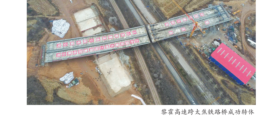
黎霍高速跨大焦铁路桥成功转体
