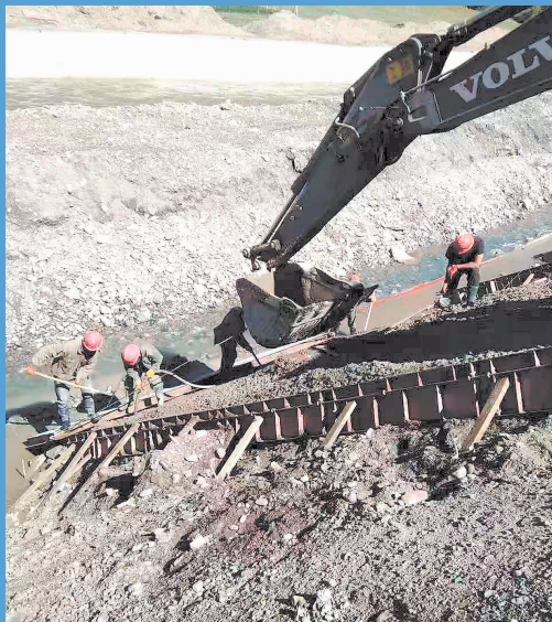
色曲河防洪治理工程护坡混凝土浇筑
