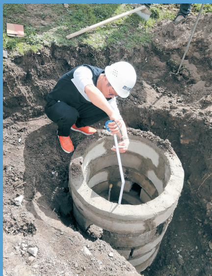
达马镇镇支隆村监理现场检查水井深度
