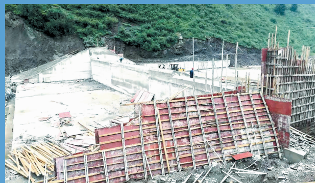
温拖引水工程一标段溢流坝施工现场
