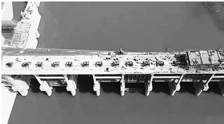
项目建设现场
