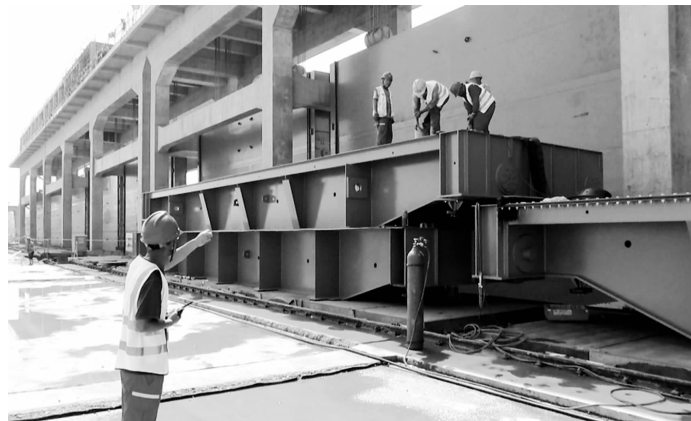
巡逻各施工点位
