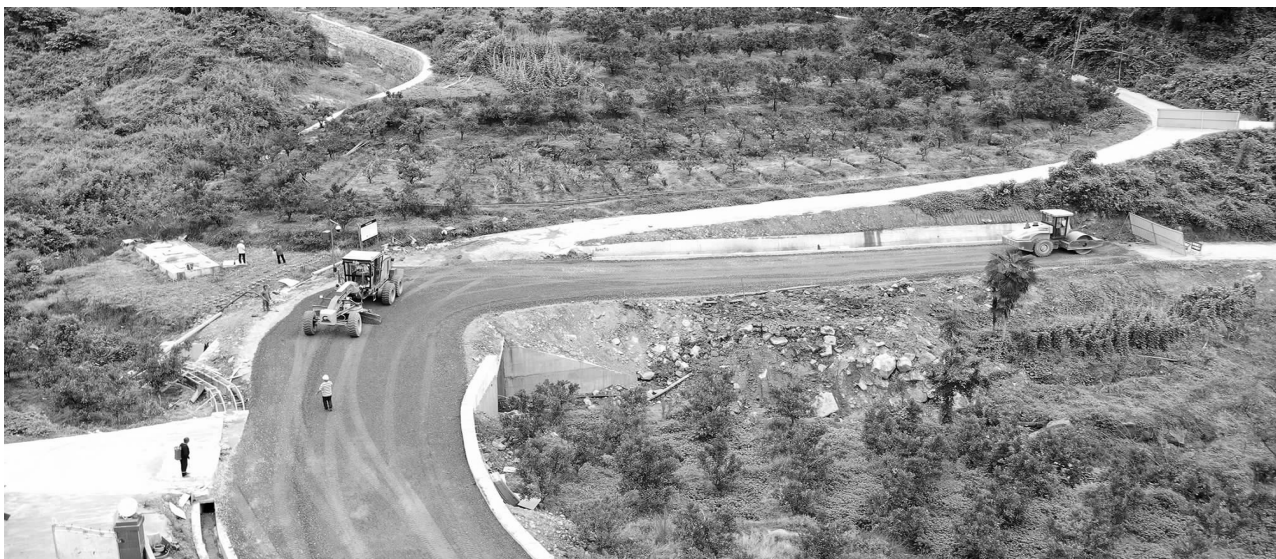
丹棱县长秋山旅游公路项目(二标段)施工现场。程欢悦 摄
