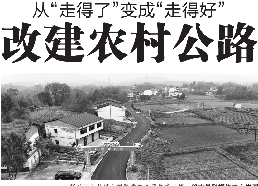
邻水县八耳镇八蚂路幸福美丽改建工程。邻水县融媒体中心供图
