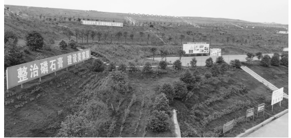
龙蟒矿业公司的磷石膏渣山上绿装
