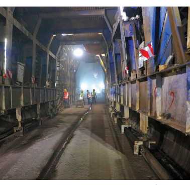
护国隧道贯通。王超明 摄
