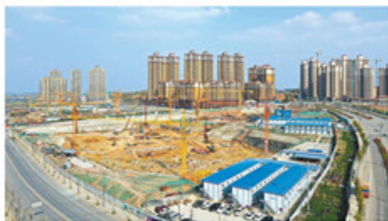
简阳重大文化民生工程——“东来印象”加快建设
