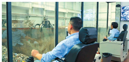
垃圾吊控制室。
