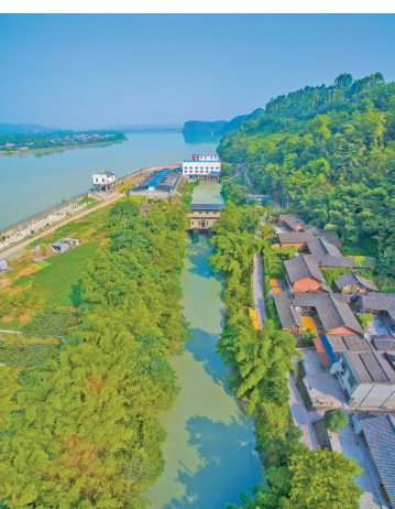
东风堰取水口。
