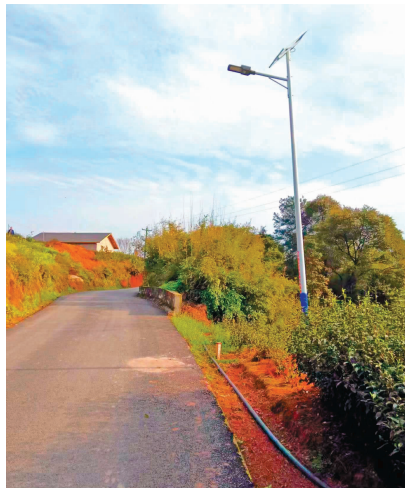
干净平整的村道。
