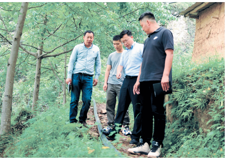
水利厅综合帮扶队员现场检查自来水管网
