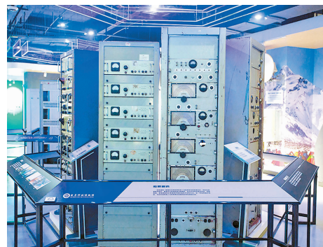
应急通信设备
