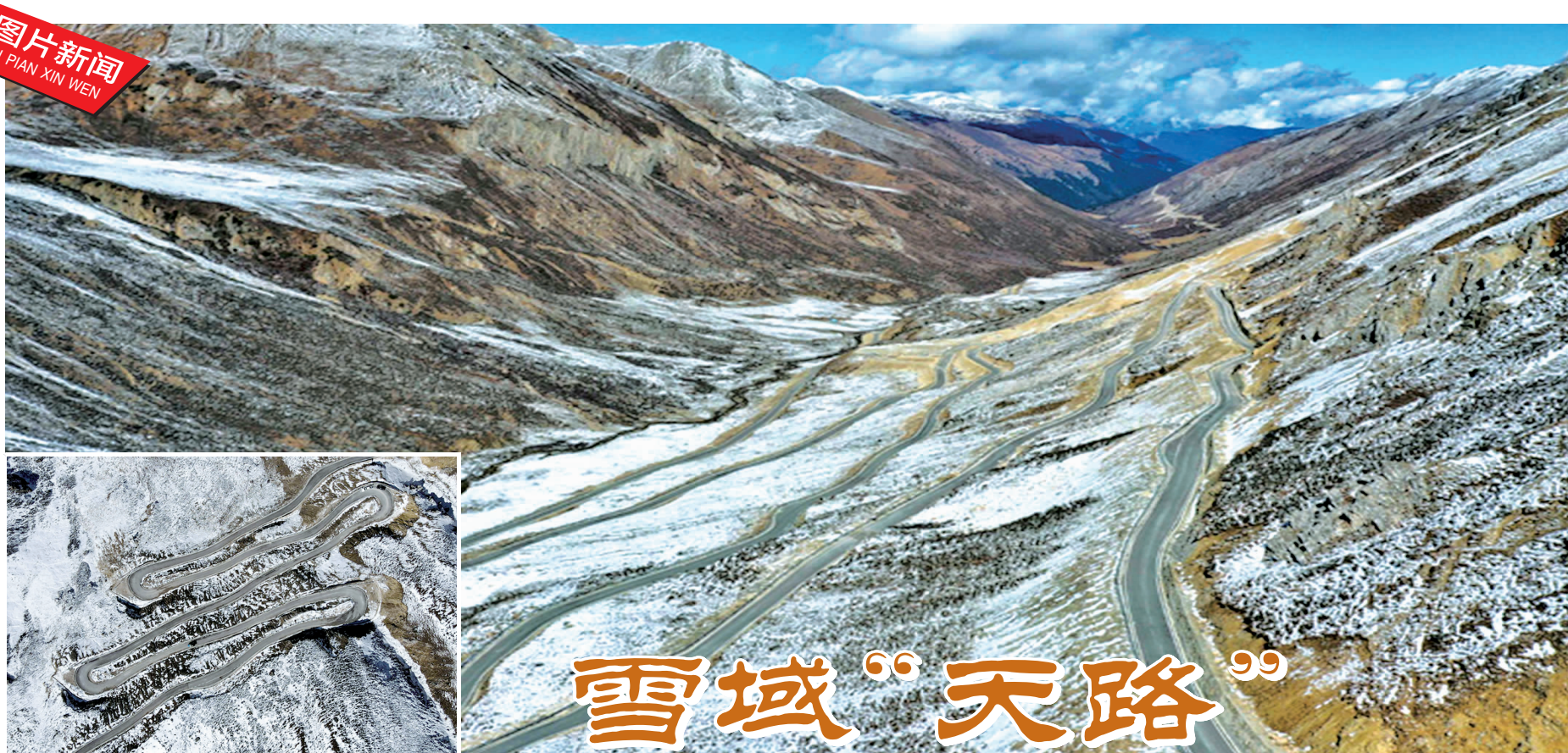
近年来,甘孜州打通交通基础设施“最后一公里”,全面实现“乡乡通油路、村村通硬化路”,交通条件得到了根本性改善。图为甘孜州巴塘县境内通往藏巴拉雪山垭口的公路。(新华社记者 胥冰洁 刘坤 摄影报道)
