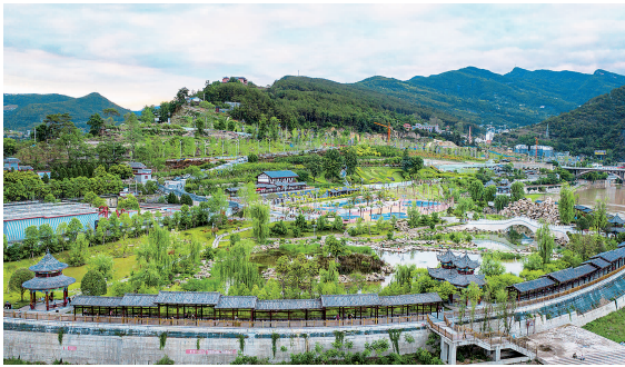
断渠湿地公园
