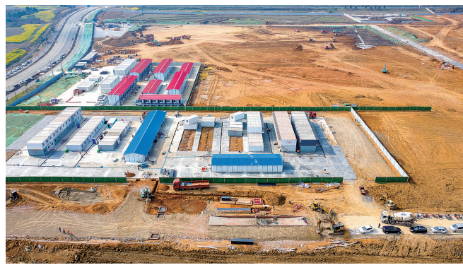
正在建设的杉杉科技眉山年产20万吨锂电池负极材料一体化基地
