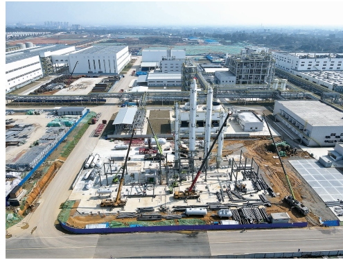
眉山高新区绿色产业园正在建设的新能源新材料项目
