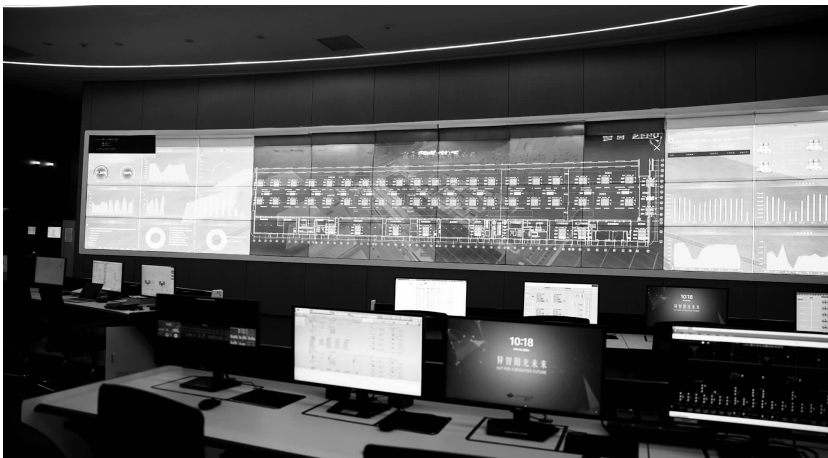
眉山升光光伏科技有限公司数字化控制中心。
