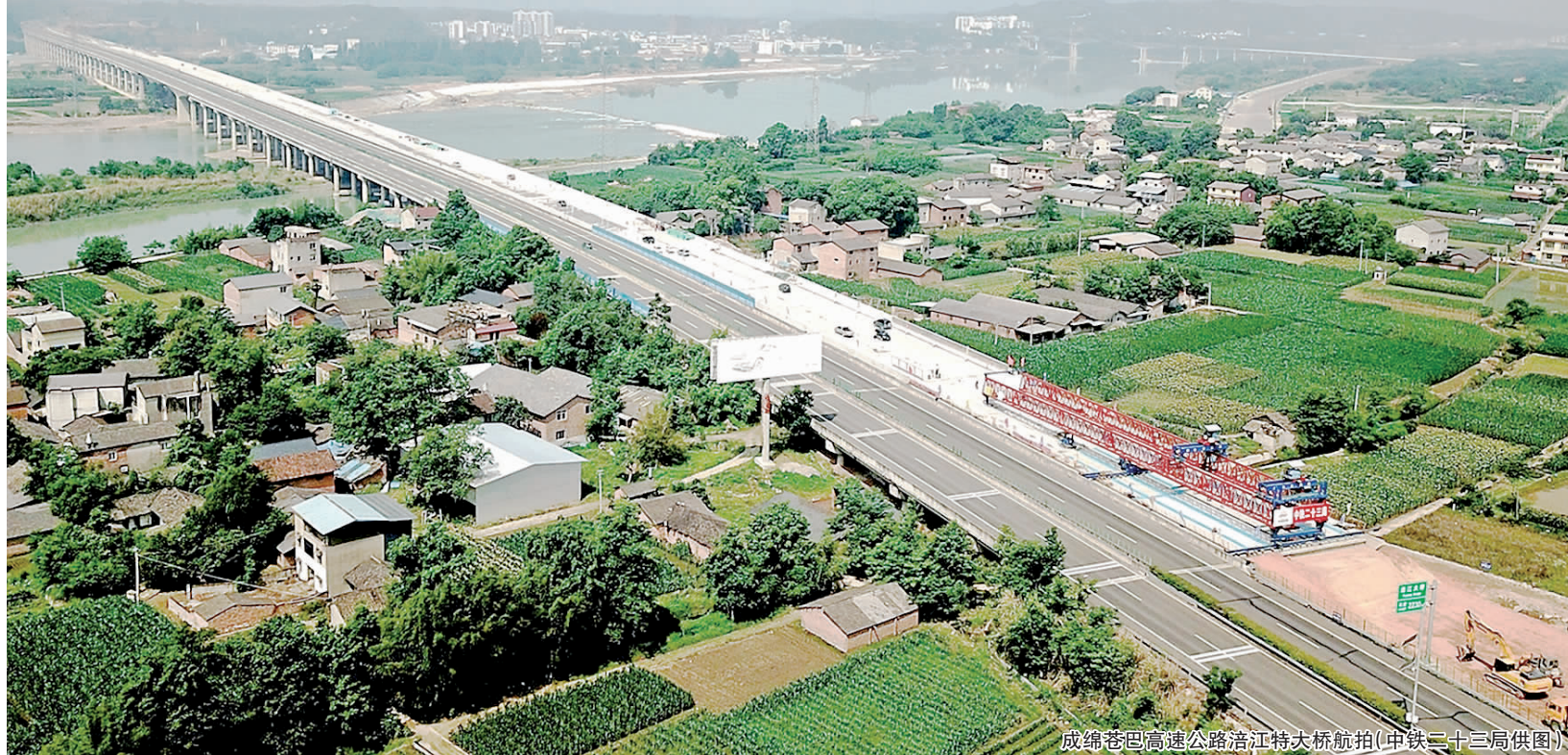
成绵苍巴高速公路涪江特大桥航拍(中铁二十三局供图)
