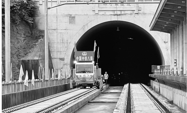
轨道牵引车牵引着长轨通过成兰铁路高川站
