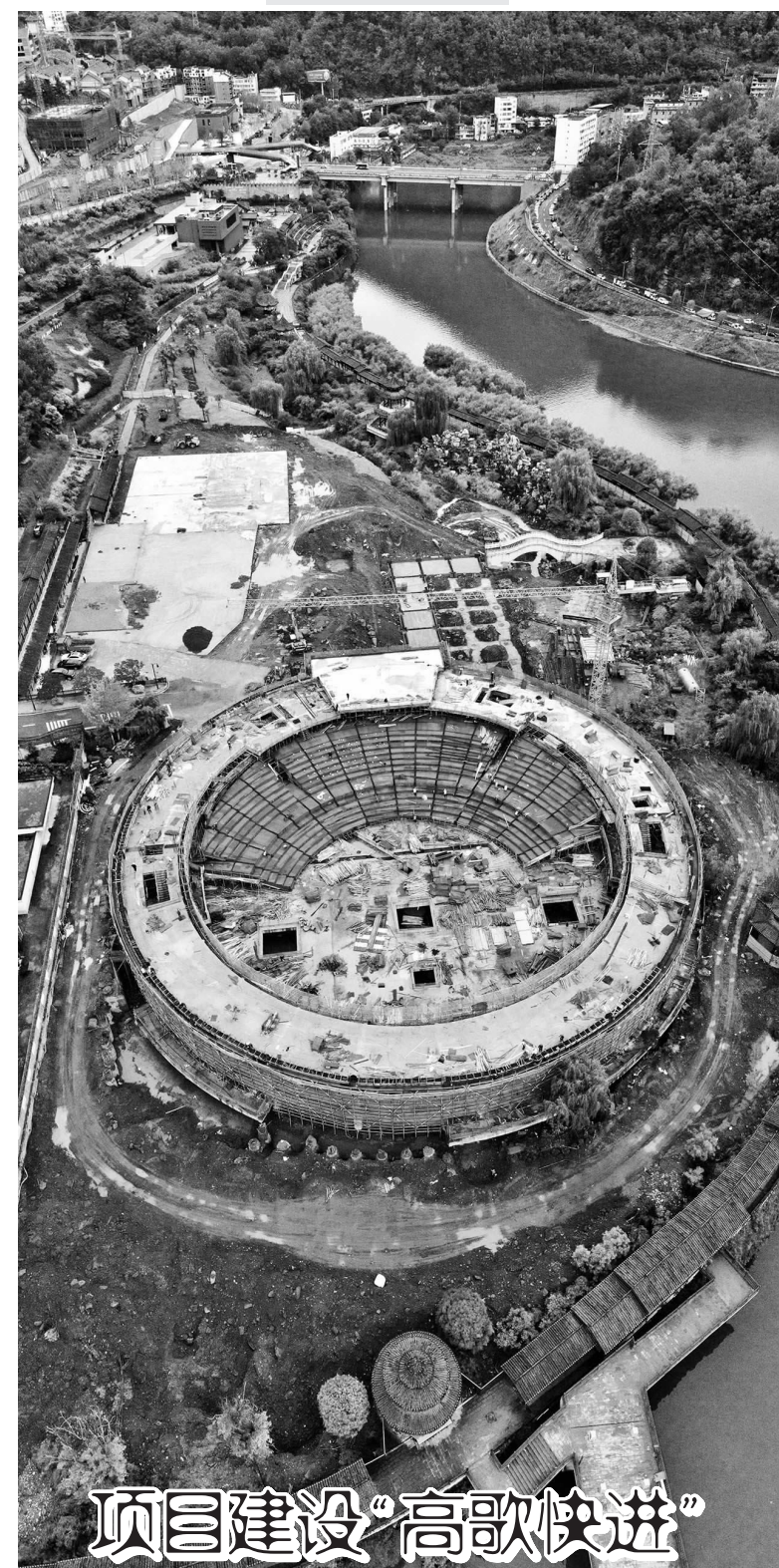
5月19日,在巴中市南江县断梁旅游景区2万余平方米的“幻享·米仓道”演艺中心项目建设工地,施工队正加班加点施工,计划10月上旬竣工交付。
