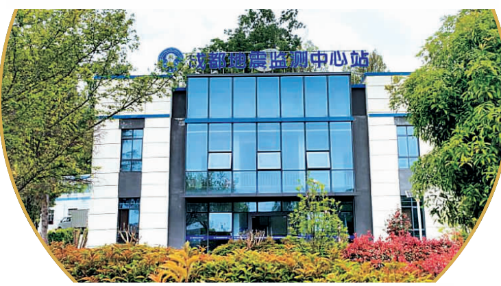
▲成都地震监测中心站。图源郫都区应急局微信公众号
