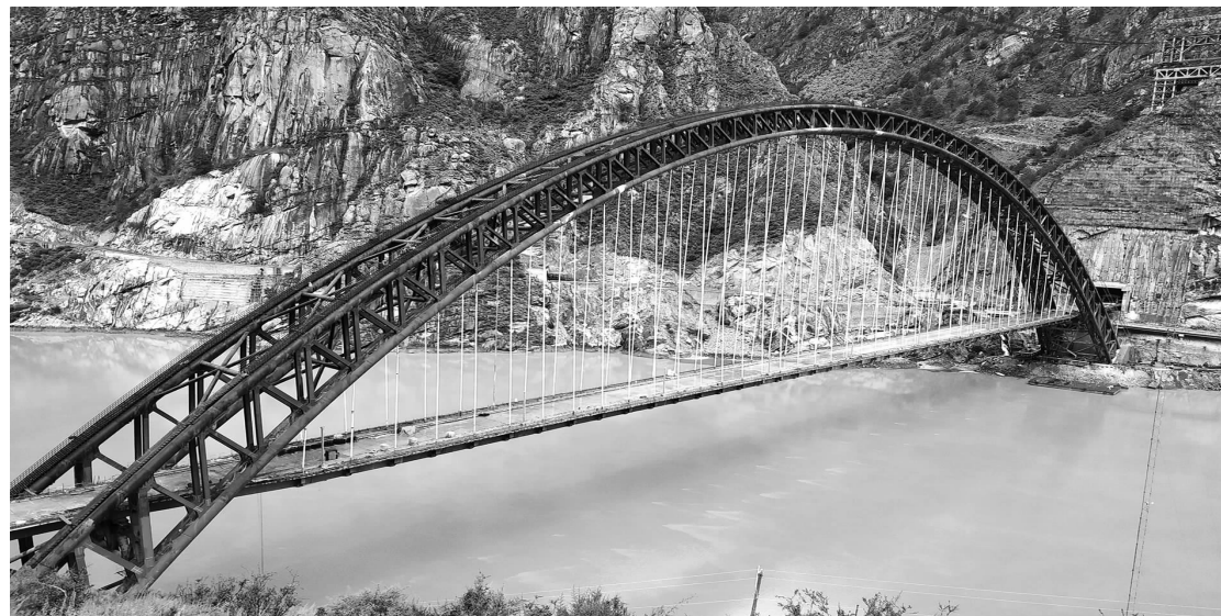
拉林铁路藏木雅鲁藏布江特大桥
