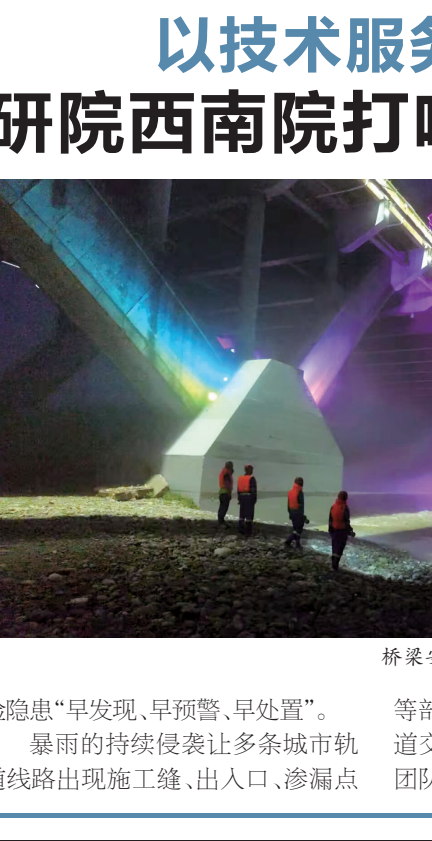
桥梁安全巡检。中铁科研院西南院供图
