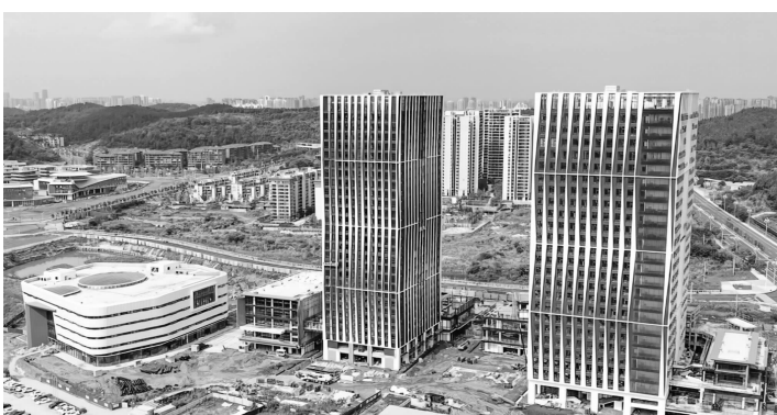
项目主体结构已完工。
